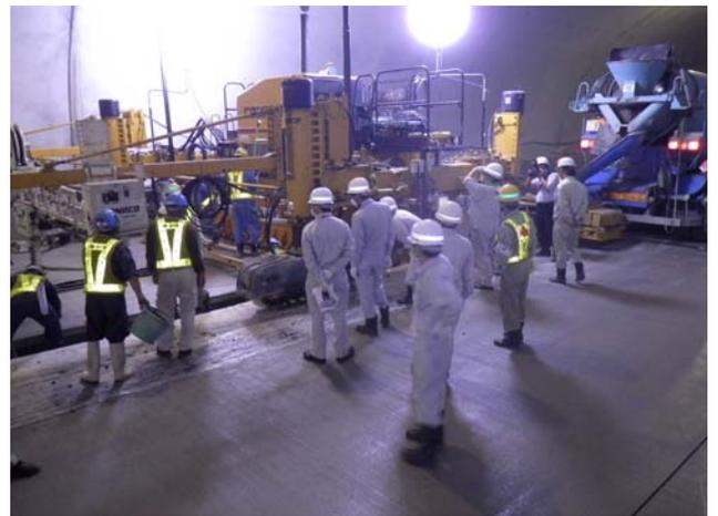
コンクリート舗装を行っている所ですがマシンコントロール技術を活用したスリップフォーム工法では、高さの調整とハンドリングも自動制御しています。
